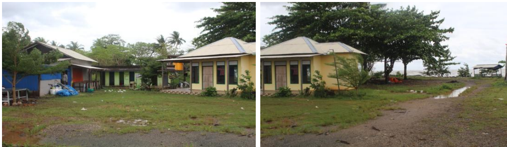
Gambar 4. 34 Kantin, Toilet dan Musholla di Pantai Tanjung Dewa
