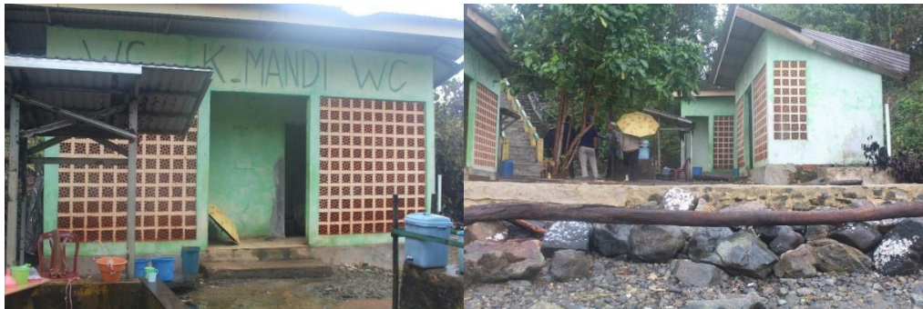
Gambar 4. 47 Toilet di Pulau Datu
